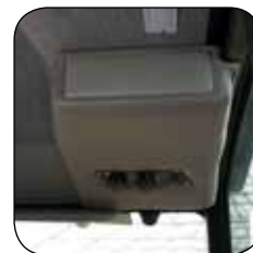
Voorziening voor audio-installatie
